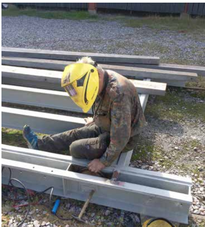
Åstrand har renoverat och målat slipvagnen.
