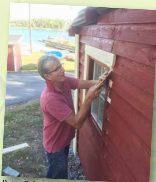
Peter Eckerbom fodrar fönstret som skänkts av Vimmerby Fönsterfabrik.
