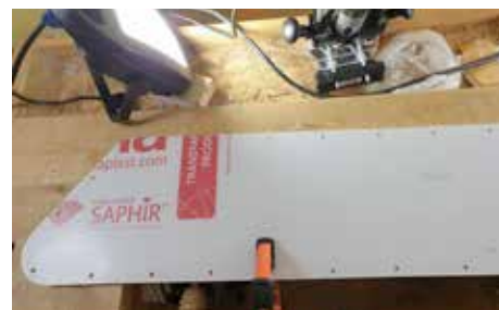
Hålen borrades något större än skruven. Det gör att rutan kan röra sig något utan att riskera att det spricker. Jag använde ett HSS-borr för trä för att borra någon millimeter djupt, och bytte sedan till ett HSS-borr för stål för att borra resterande. Träboret ger en fin och skarp kant, och man får mycket god precision av centrumnålen. Men stålborret tål mer och har en bättre avverkning, och jag valde därför att bara använda träboret för att få hålet på rätt plats.
