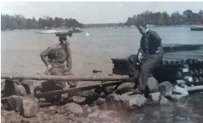
Torvald Andersson och Arnold Nord bygger brygga på Solbergsudde
