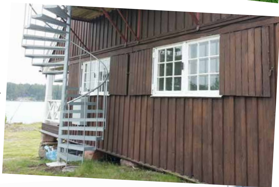
Brandtrappan färdig monterad
